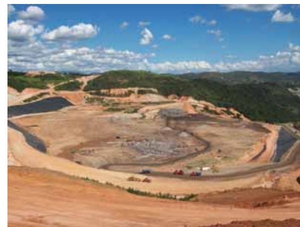
Foto 12: Aterro Sanitário de Sabará - MG
