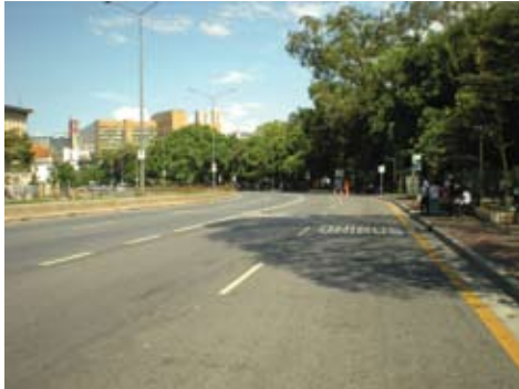
Figura 13 – Trecho com pavimentado com asfalto borracha em Belo Horizonte (MG)
